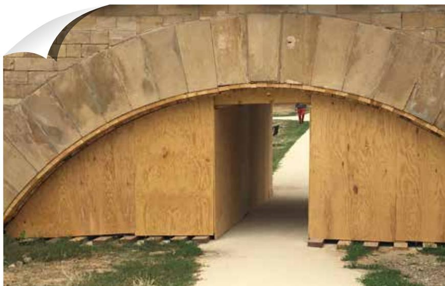
Lors d'une étude sur les ouvrages d'art par GPS&O, il a été constaté un léger mouvement de la clef de voûte au niveau de la première arche du pont aux Perches (côté quai de l'Arquebuse). Un étaielement de la voûte a été réalisé afin de consolider la structure du pont.
