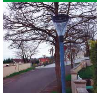
Nouveaux candélabres de l'allée Pompadour
